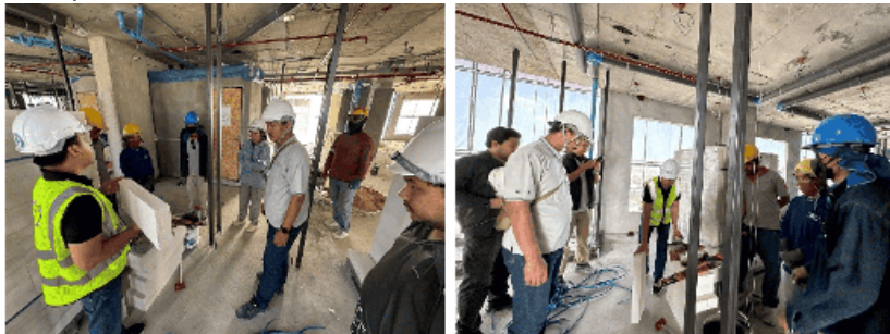
อบรมงานก่ออิฐ
