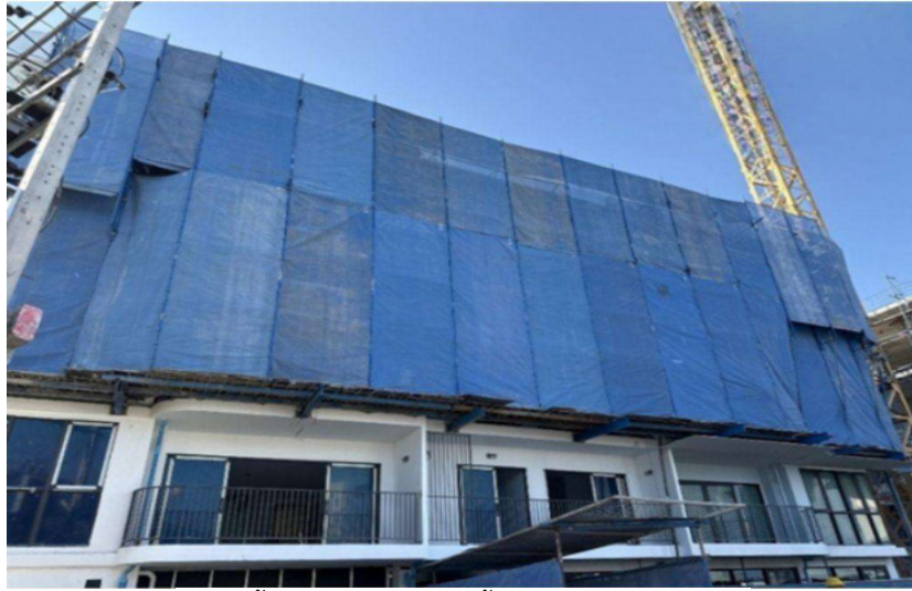
การติดตั้ง mesh sheet เพื่อป้องกันฝุ่นและวัสดุตกหล่น
