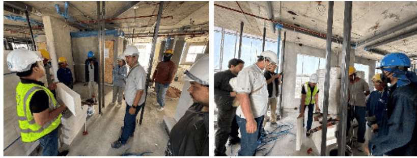
อบรมงานก่ออิฐ
