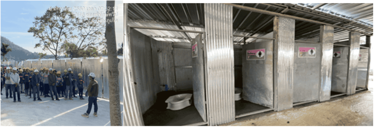
ห้องน้ำในแคมป์คนงาน
