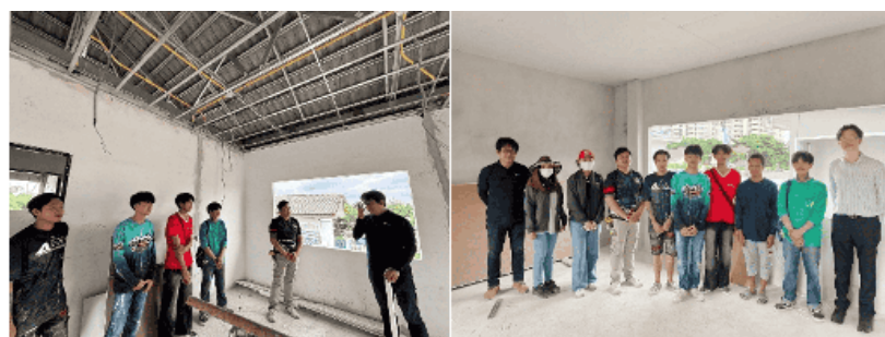
อบรมมาตรฐานงานติดตั้งฝ้า
